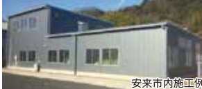
安来市内施工例
