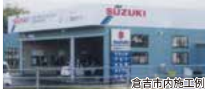
倉吉市内施工例
